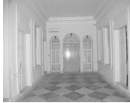
Şekil 9 Restorasyon sonrası zemin kat sofa
