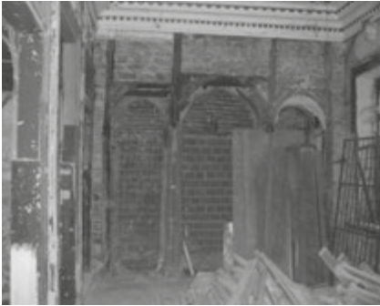
Şekil 8 Sofada raspa ile bulunan açıklık
