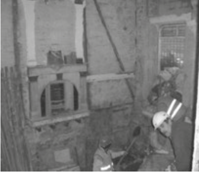
Şekil 10 Araştırma kazısında bulunan bodrum ve ahşap döşeme kirişleri.
