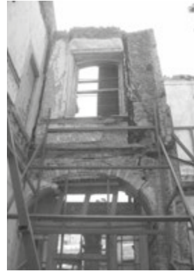
Şekil 5 T bağlantı duvarı.
